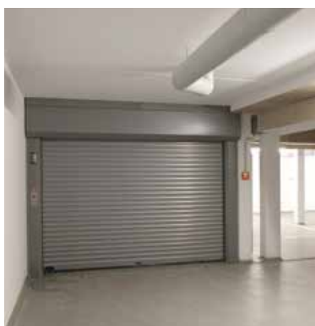
Rolltor und Ampelanlage in dezenter Optik in der unteren Haltenstelle
