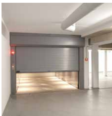
Rolltor und Ampelanlage in dezenter Optik in der unteren Haltenstelle
